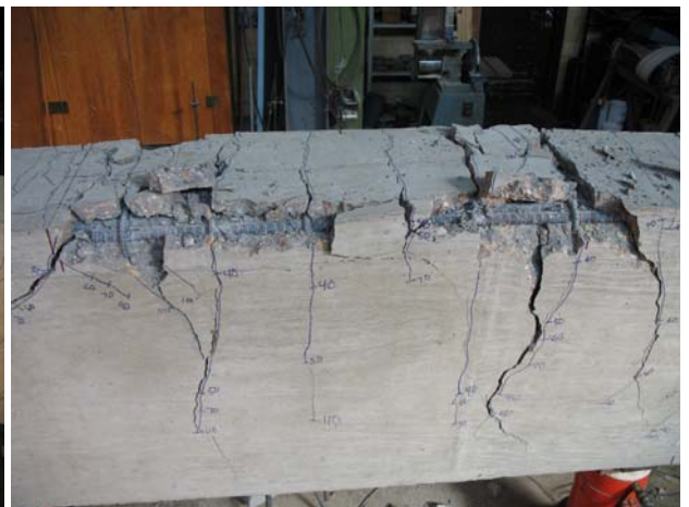
(d) 8-8-3-OC2: Side Split Failure
